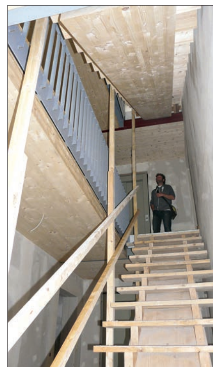
Staufen: Treppenhaus mit BSP-Elementen in Decken, Wänden und Treppe
