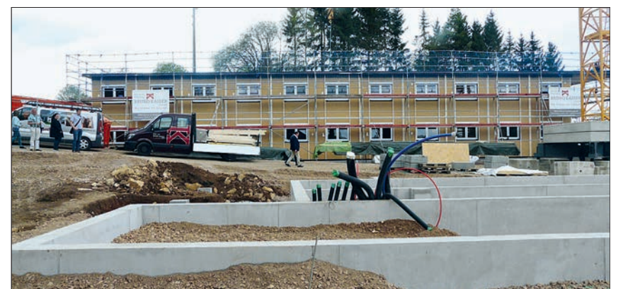
Löffingen im Schwarzwald: Modular aufgebautes Flüchtlingswohnheim von Holzbau Bruno Kaiser in Holzrahmenbauweise.
