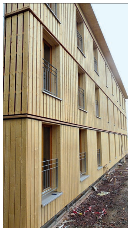
Alles rückbaubar: Modulwohnheim in Freiburg (Gundelfinger Straße)
